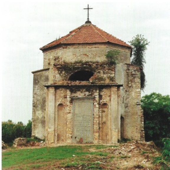
Figura 7: San Rocco prima della ristrutturazione
